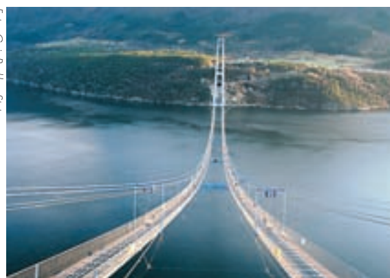
Hardangerbron (1380 meter) i Norge blir en av de längsta hängbroarna i världen, med ett huvudspänn på 1310 meter. Bron kommer att öppnas under 2013.
